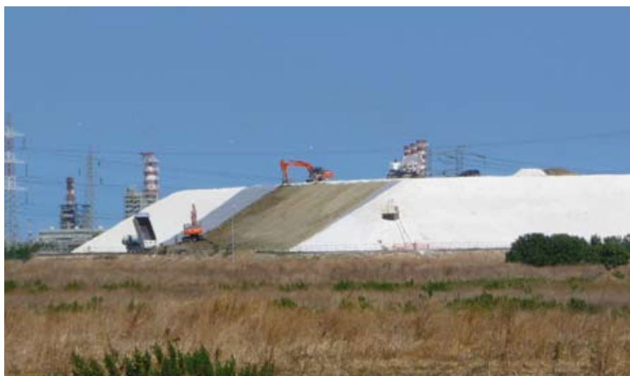
Copertura definitiva discarica di rifiuti non pericolosi – Brindisi (BR)
